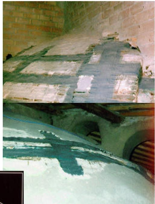
Fig. 1 - 2 - 3 - 4 - 5 - *Duomo di Città di Castello (PG)* - Cerchiatura con fibre di carbonio dell'estradosso di cupole in muratura di mattoni lesionate. Intercettazione ed eliminazione dell'innesco del cinematisimo (disconnessione degli elementi in fase sismica) attraverso maglia in fibra disposta secondo meridiani e paralleli.
