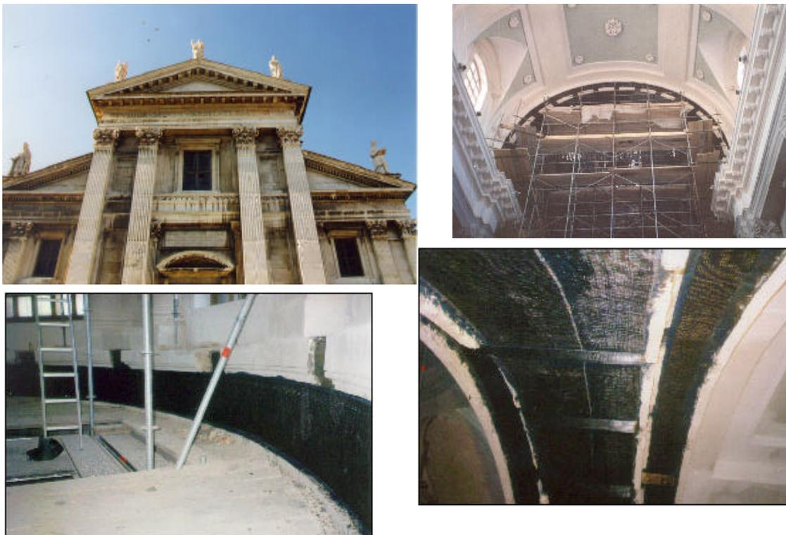
Figure 9 . 10 . 11 . 12- *Duomo di Urbino - Urbino* – Fornitura di fibre di carbonio compreso il trasferimento tecnologico con consulenza specialistica al personale tecnico ed operativo per il lavoro di consolidamento e miglioramento sismico della Cattedrale di Urbino (intervento sul tamburo della cupola, sul transetto, l'abside e le travi di collegamento lignee della navata principale).
