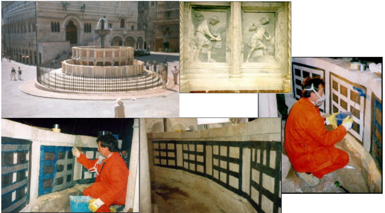
Fig. 13 - 14 - 15 - 16 - 17 - 18 - *Fontana Maggiore - Perugia* - Rinforzo, confinamento e collegamento tramite FRP delle formelle di marmo realizzato all'interno del bacino inferiore della Fontana Maggiore di Perugia (XIII sec.). Nel caso specifico l'intervento è consistito nell'applicazione controllata di nastri di fibre di vetro con preventiva fase di rilievo dello stato fessurativo delle formelle anche con metodi non distruttivi, e relativa schedatura ed informatizzazione.
